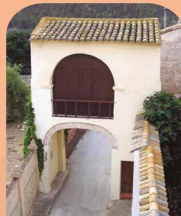
El conjunto presenta dos alturas, tal y como viene siendo habitual en este tipo de construcciones. La inferior muestra diferencias entre sus fachadas interna y externa. De este modo, intramuros se abre por medio de un sencillo arco rebajado, mientras que extramuros lo hace con arco de medio punto.
